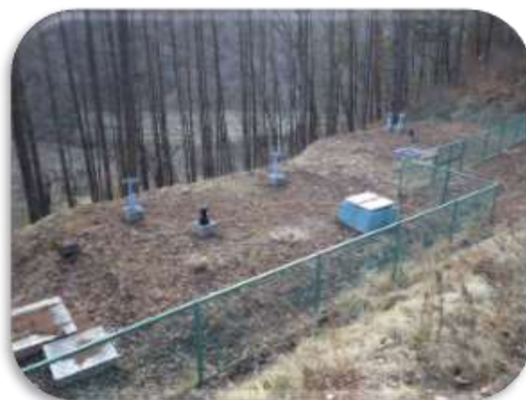
京の岩配水池
