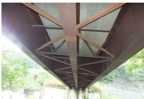
健全度 II : 大緒橋
