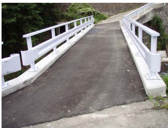
健全度 I : 坂下橋
