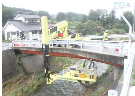
写真 2. 橋梁点検車による点検
