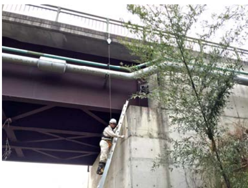
写真 1. 梯子による点検
